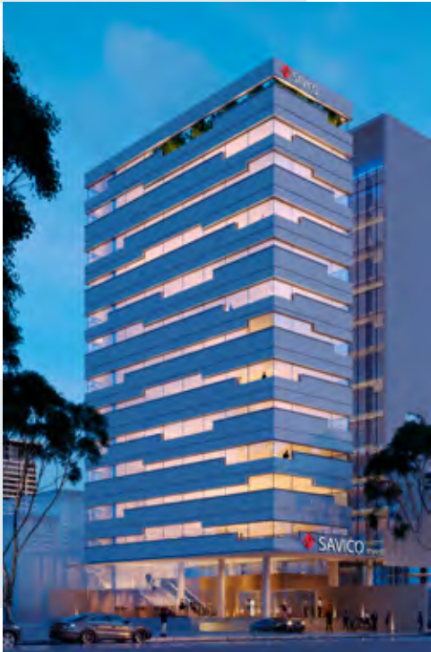
Dự án 66-68 Nam Kỳ Khởi Nghĩa - Savico Invest Đã nhận được giấy phép xây dựng, Khởi công xây dựng từ ngày 21/02/2018, Đang thực hiện thi công móng hầm.
