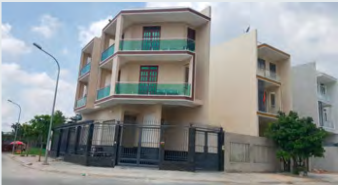
Dự án KDC Hiệp Bình Phước - Tam Bình Đang thi công bờ kè, cảnh quan theo đúng tiến độ và sẽ bàn giao cho địa phương quản lý.
