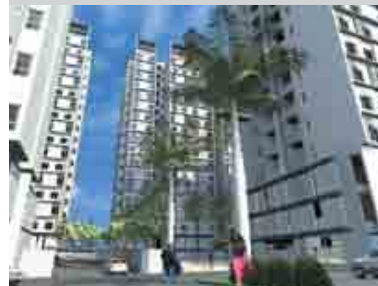
DỰ ÁN KHU CĂN HỘ CAO TẦNG HIỆP BÌNH PHƯỚC - TAM BÌNH, THỦ ĐỨC
